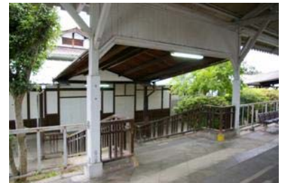
畝傍駅貴賓室からホームに上がる階段
